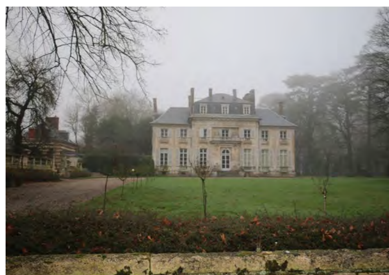
Figure 71 : Château, communs et parc de Saint-Gratien
